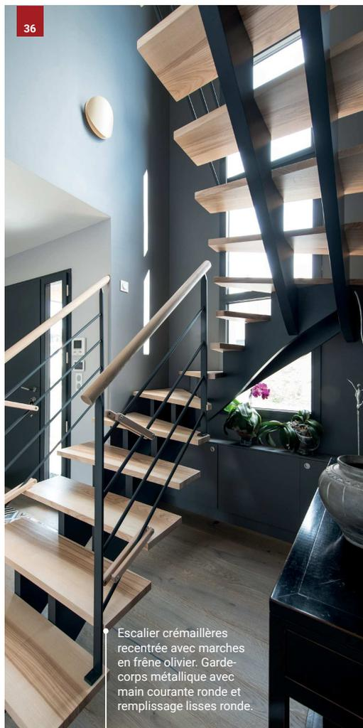
Escalier crémaillères recentrée avec marches en frêne olivier. Garde-corps métallique avec main courante ronde et remplissage lisses ronde.
