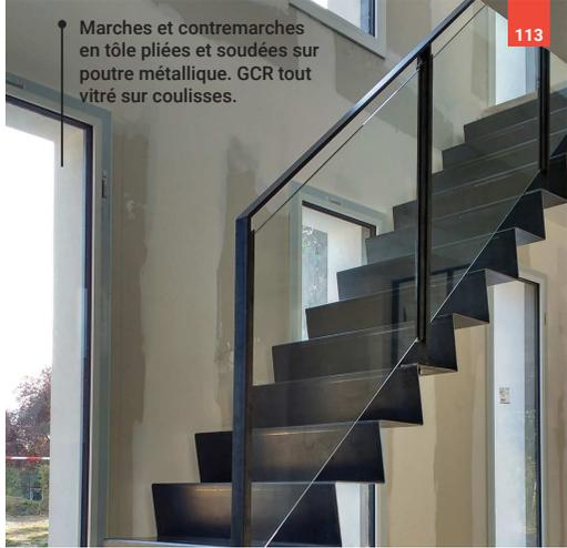
Escalier suspendu avec 2 marches palières de départ - GC Rampant métallique fer plat avec remplissage vitrage sur coulisse.
