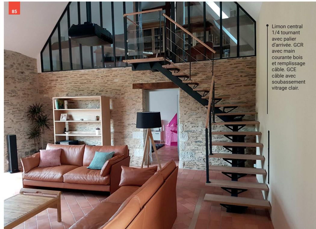
Limon central 1/4 tournant avec palier d'arrivée. GCR avec main courante bois et remplissage câble. GCE câble avec soubassement vitrage clair.
