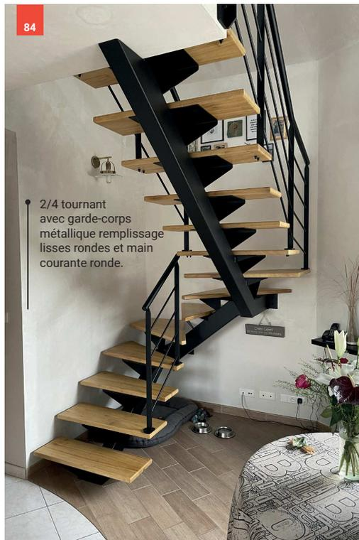
2/4 tournant avec garde-corps métallique remplissage lisses rondes et main courante ronde.
